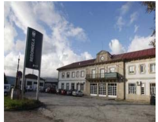
Estación ferroviaria de Redondela antes de las nuevas obras.
